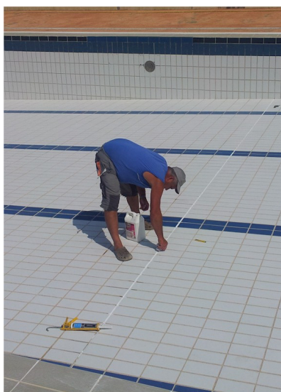
Réfection du carrelage des deux bassins de la piscine
