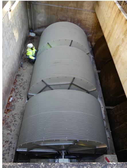
24/10 : Remplacement d'un Biodisque de la station d'épuration
