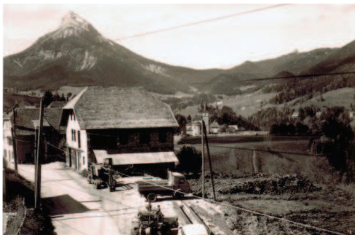
Travaux à Baffardière
