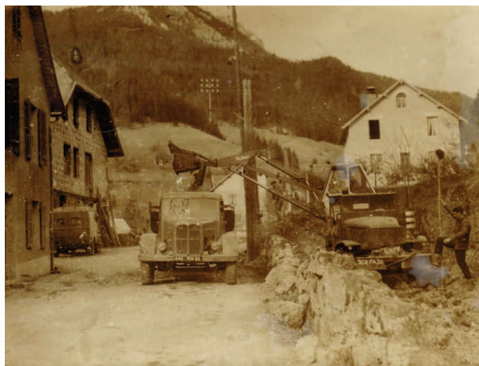
Travaux à Baffardière
