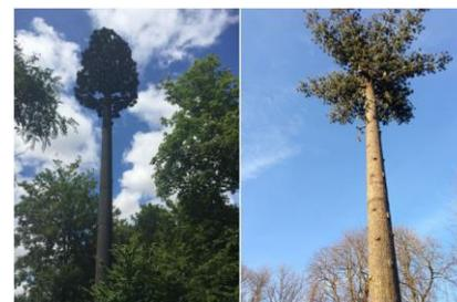
*De faux arbres dans les Yvelines. Dans d'autres cas ce seront des toits comportant de fausses cheminées avec des antennes à l'intérieur*
