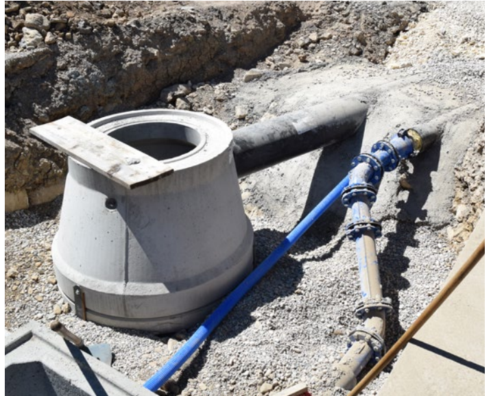
Rénovation des réseaux d'eau potable et assainissement au hammeau de Cherlieu en 2022
