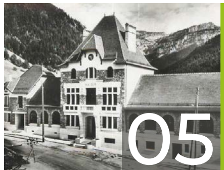
Réhabilitation de l'ancienne mairie
